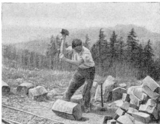
Рабочий выкалывает из колонн базальта камни для мостовых. Чехословакия. Снимок автора, 1936 г.
