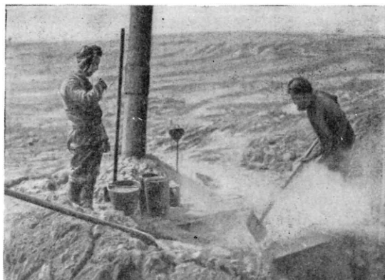
Выплавка полужидкого камня озокерита — горного воска. Остров Челекен на Каспийском море. Снимок автора, 1929 г.
