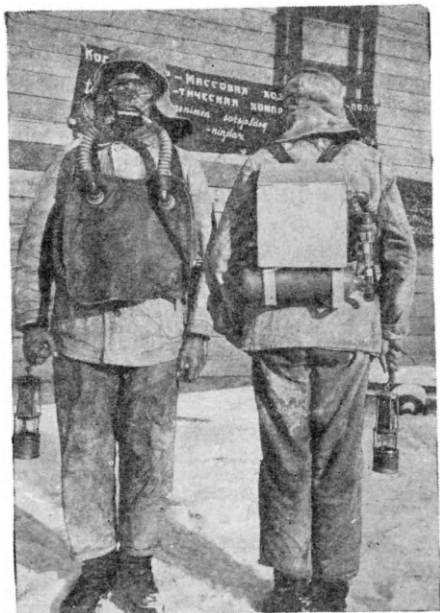
Кислородные приборы для работы в шахтах свинцового и цинкового рудника Риддера на Алтае.
