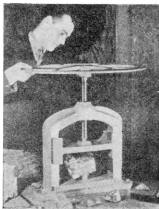
Ручной пресс для формовки минералов и горных пород.
